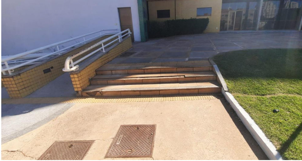
5 - Escada Auditório (Corrimões Laterais e Piso Alerta)
