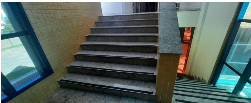
3 - Escada 2º Andar (Piso Tátil Alerta + Corrimões Laterais, Talvez Guarda-Corpo)
