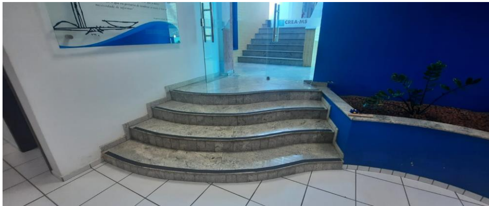
1 - Escada Atendimento (Piso Tátil Alerta + Corrimões Laterais + Corrimão Central)
