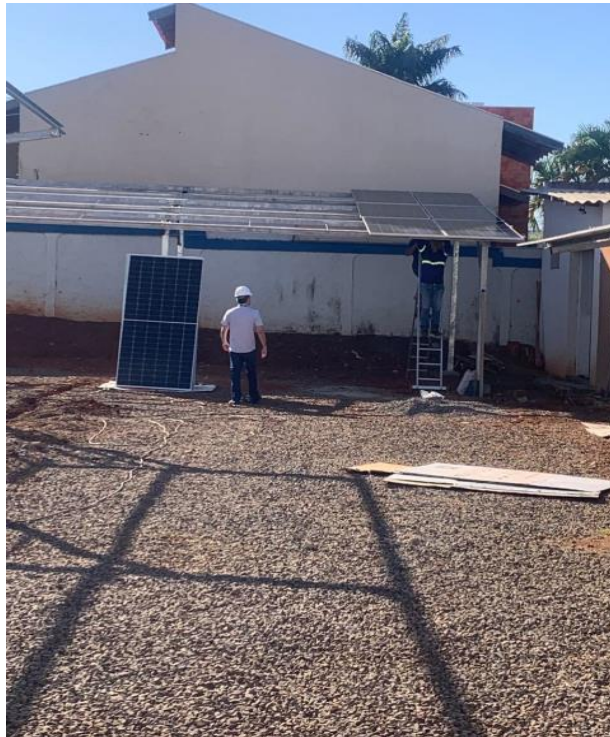
Imagem 17 – Instalação das placas do Carport
