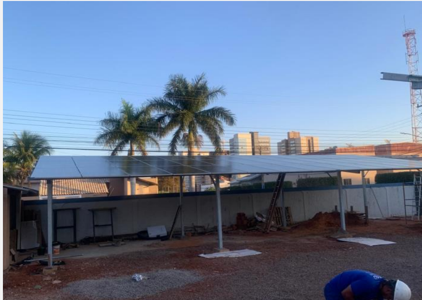
Imagem 18 – Instalação das placas do Carport
