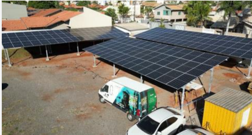
Imagem 02 - Placas do Carport finalizados
