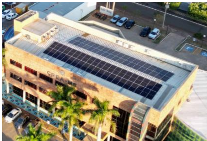
Imagem 01 - Placas da cobertura finalizadas
