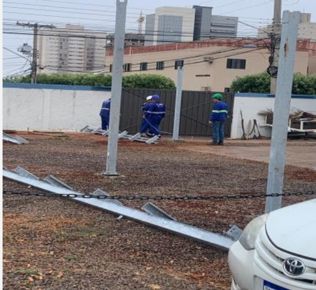
Imagem 07 – Instalação das vigas e terças metálicas do Carport
