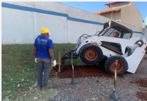
Imagem 02 – Escavação da fundação do Carport
