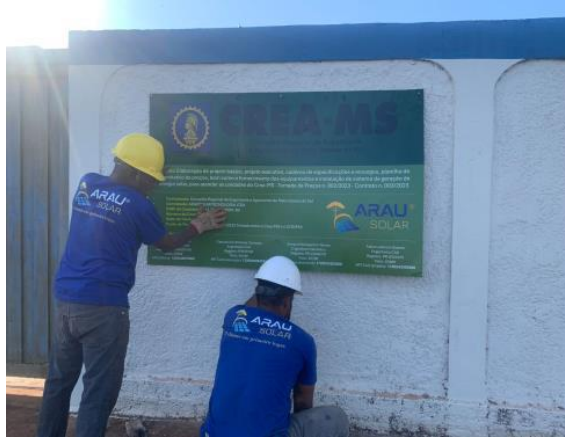
Imagem 01 - Instalação da placa da obra
