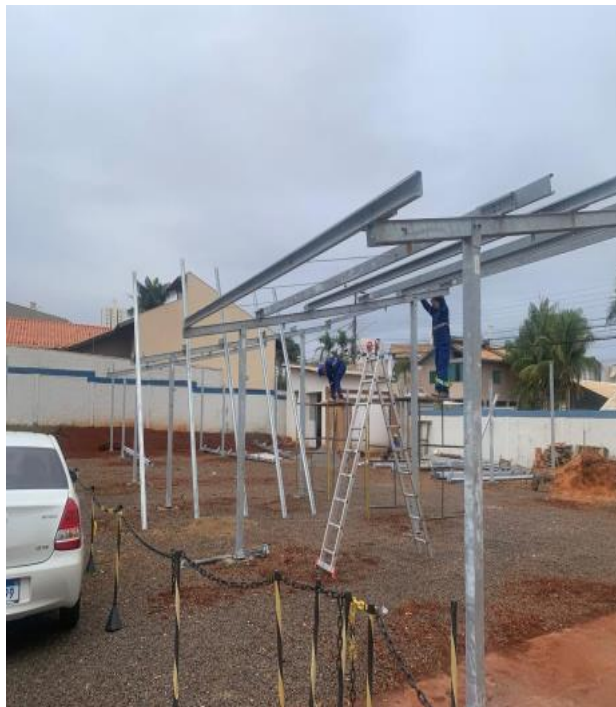
Imagem 07 – Instalação das vigas e terças metálicas do Carport
