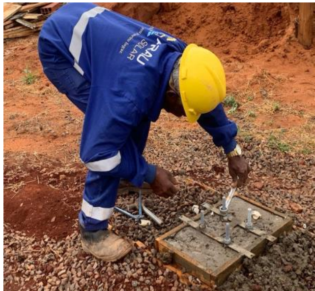
Imagem 05 – Desforma dos elementos de fundação
