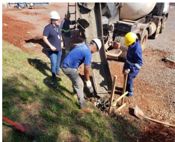
Imagem 03 – Concretagem da fundação dos Carports
