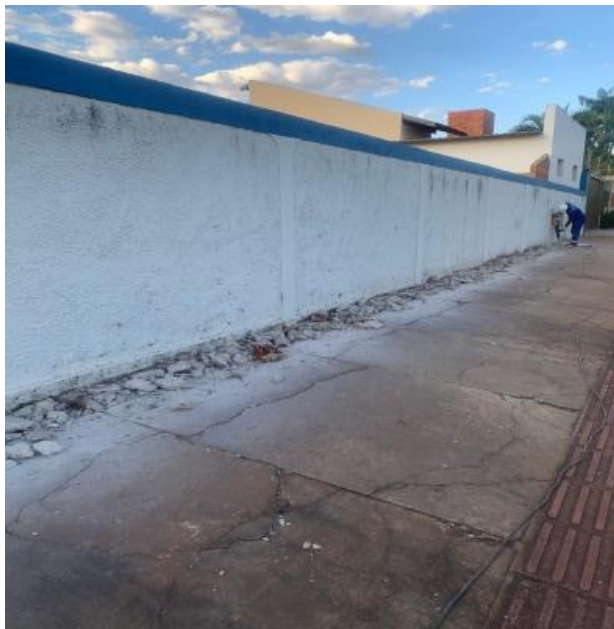
Imagem 09 – Quebra de piso de calçada para passagem de infraestrutura elétrica
