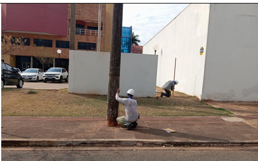
Foto 3.7 – Determinação do RN (poste de energia), localizado em frente ao terreno, na rua Antônia de Castro Faria.
