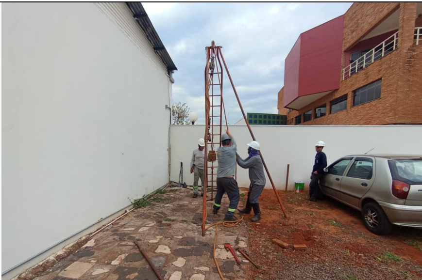
Foto 3.3 – Execução do SPT-02.
