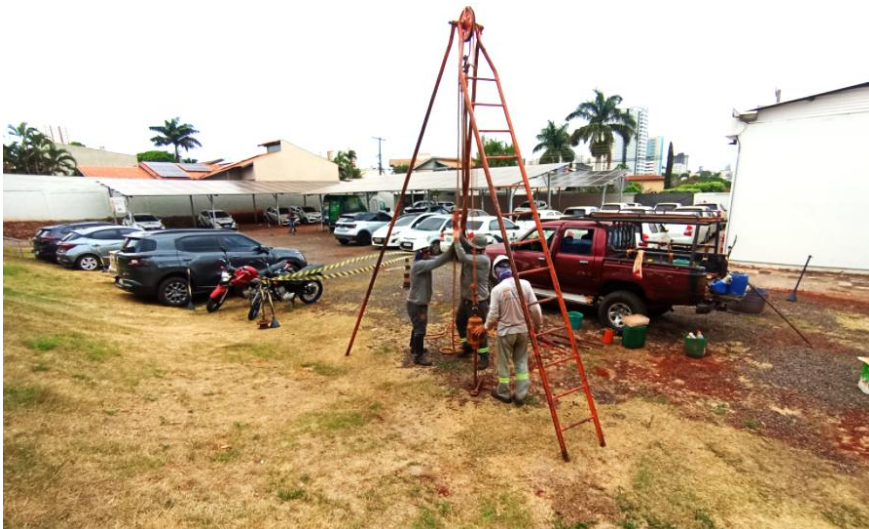
Foto 3.1 – Execução do SPT-01.
