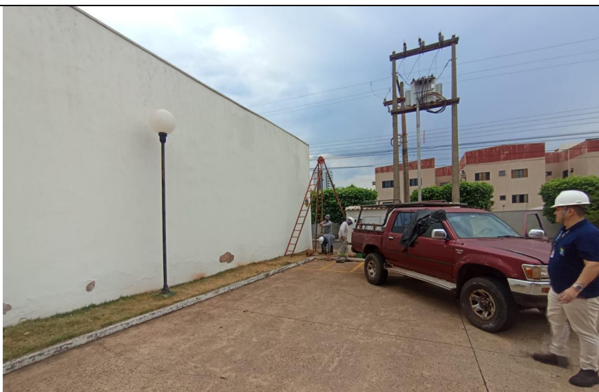
Foto 3.5 – Execução do SPT-03.
